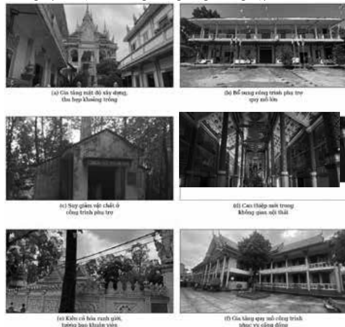
Hình 1. Một số biểu hiện hiện trạng và can thiệp tại các chùa Khmer khảo sát. Nguồn: Ảnh khảo sát thực địa của tác giả
