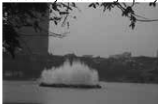
a. Hệ thống vòi phun nhờ máy bơm tại hồ Thành Công (Hà Nội)
