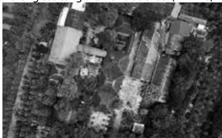
Hình 18. Chùa Tôn Thạnh, Long An - Trường hợp cải tạo hợp lý [1]
