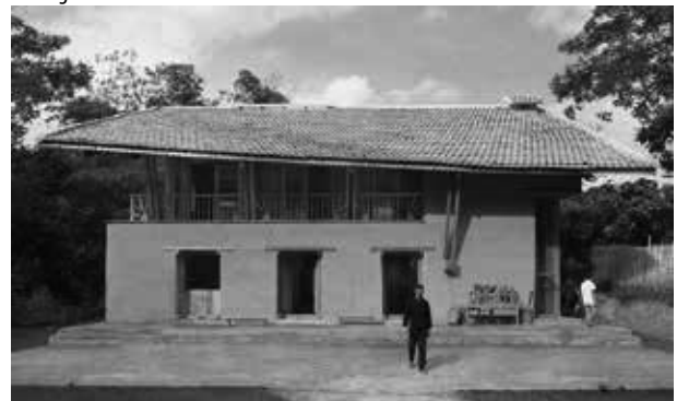
Hình 4. Nhà cộng đồng & Homestay Nậm Đăm, Hà Giang, một ví dụ về áp dụng vật liệu trình tường vào công trình kiến trúc hiện đại
