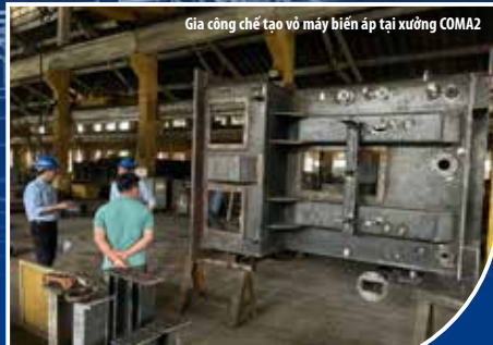
Gia công chế tạo vỏ máy biến áp tại xưởng COMA2
