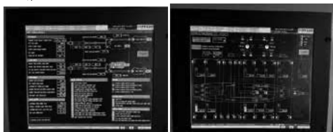
Hình 9. Giao diện vận hành của hệ SCADA đang hoạt động trên tàu
