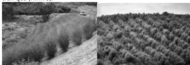
Hình 3. Gia cố mái đất dốc bằng biện pháp trồng cỏ và trồng rừng, phủ xanh đồi trọc
