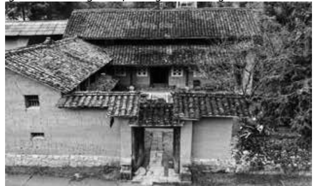
Hình 3. Nhà cổ Chung Pủa của người Hmông ở Hà Giang được xây dựng bằng vật liệu trình tường
