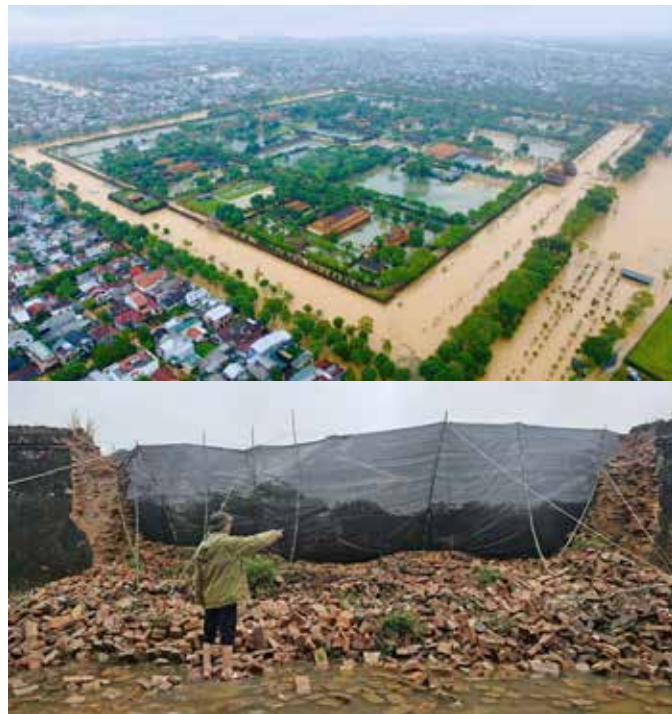
Hình 2: Hình ảnh khu vực Đại Nội Huế - Di sản văn hoá thế giới được UNESCO công nhận - bị nhấn chìm trong biển nước và đoạn tường thành cổ bị đổ sập do mưa bão cuối tháng 10/2025. (nguồn ảnh: sưu tầm)
