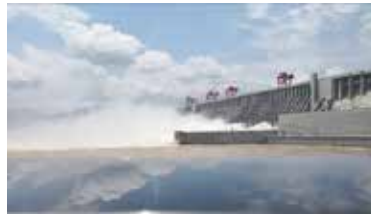
Hình 5a, 5b: Đập Tam Hiệp và hệ thống hồ chứa trên sông Tam Giang Ghi chú: Đập Tam Hiệp là hệ thống điều tiết đa chức năng, dài 2.309 m, cao 185 m, với khả năng chịu được lũ 70.000 \text{m}^3/\text{s} .
