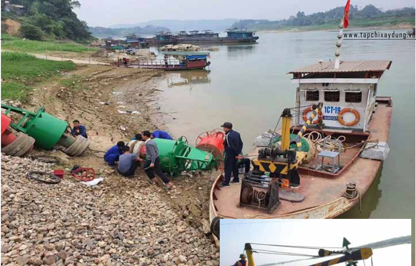
Hoạt động bảo trì đường thủy trên tuyến đường thủy quốc gia sông Lô.
