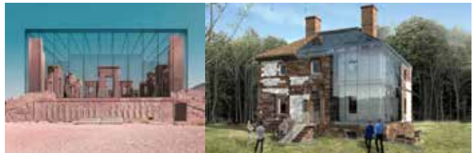
Hình 4: Hệ thống cấu trúc vách kính chống gió bão được lắp đặt để bảo tồn các di tích kiến trúc cổ có giá trị tại châu Âu và Bắc Mỹ ở các cấp độ một phần hạng mục trong công trình và toàn bộ công trình. (nguồn ảnh: sưu tầm)
