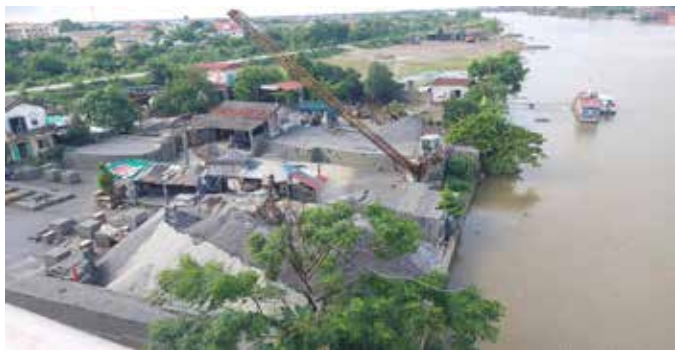
Cảng, bến thủy nội địa phải tuân thủ các quy định hiện hành về bảo trì công trình, bảo đảm an toàn kỹ thuật trong quá trình khai thác.
