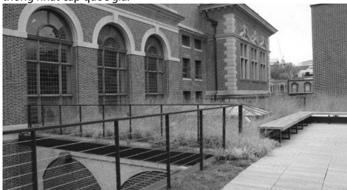
Hình 2. Một trong bảy mái nhà xanh trên tòa nhà Golkin Hall của Trường Luật Đại học Pennsylvania [5]
