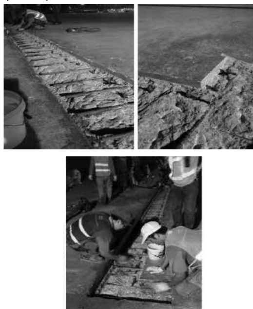
Hình 12. Cây bu-lông liên kết vào bề mặt tấm BTXM [1]
