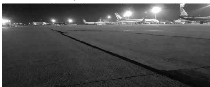
Hình 3. Tấm BTXM bị nén ép trôi trên đường công vụ A3 tại CHK quốc tế Tân Sơn Nhất [1]
