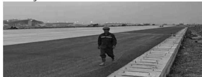
Hình 5. Hình ảnh cải tạo rãnh thoát nước tại CHK quốc tế Nội Bài [4]
