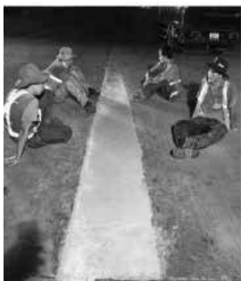
Hình 13. Đổ vữa và thi công Rigid Ground Structural HT vào vị trí trám vá [1]
