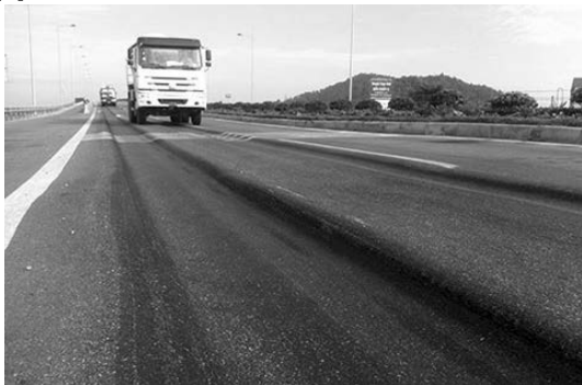
Hình 1. Hằn lún vết bánh xe dưới tác dụng tải trọng lặp lại
