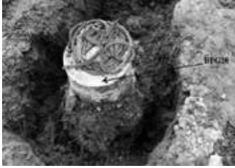
Hình 1. Đất dính bám xung quanh thân cọc khoan nhồi có phụt vữa
