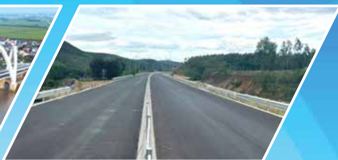
Dự án thành phần Chí Thạnh - Vân Phong thuộc Dự án xây dựng đường bộ cao tốc Bắc - Nam phía Đông
