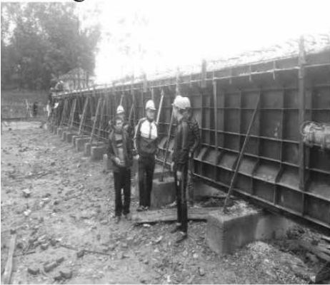
Hình 12. Thực hành tham gia sản xuất dầm I33 dự ứng lực cầu Sông Phan
