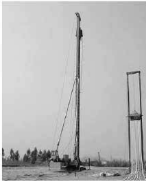
Hình 1. Thiết bị thi công giếng cát đóng túi
