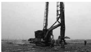
Hình 3. Thi công giếng cát đóng túi trong điều kiện đất yếu
