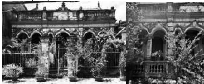
Hình 6. Chi tiết lan can con tiện, viên đá khóa và đường diềm trang trí trên mặt đứng nhà SD07
