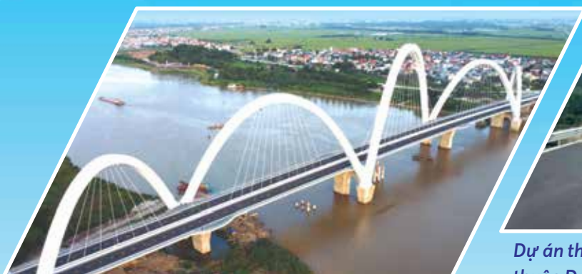
Cầu Phệt Tích (Bắc Ninh)
