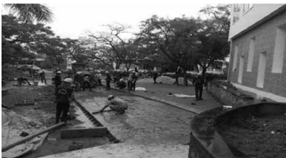
Hình 2. Sinh viên thực hành đổ bê tông đường vào khu nhà điều hành của UTT
