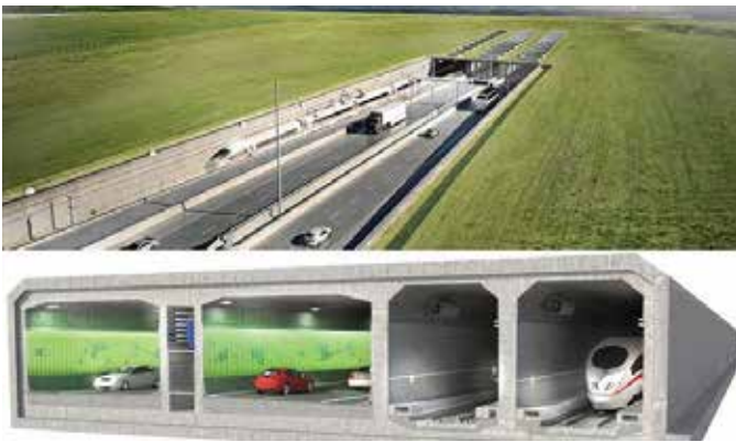
Fehmarn Belt Fixed Link là dự án hạ tầng ngầm mang tính biểu tượng toàn cầu, với tổng chiều dài 18 km, kết nối đảo Lolland (Đan Mạch) và đảo Fehmarn (Đức) dưới đáy biển Baltic.
