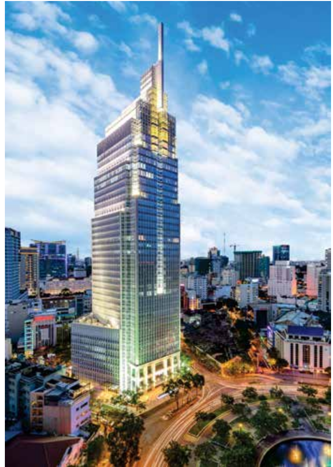
Tháp Vietcombank (LEED).
