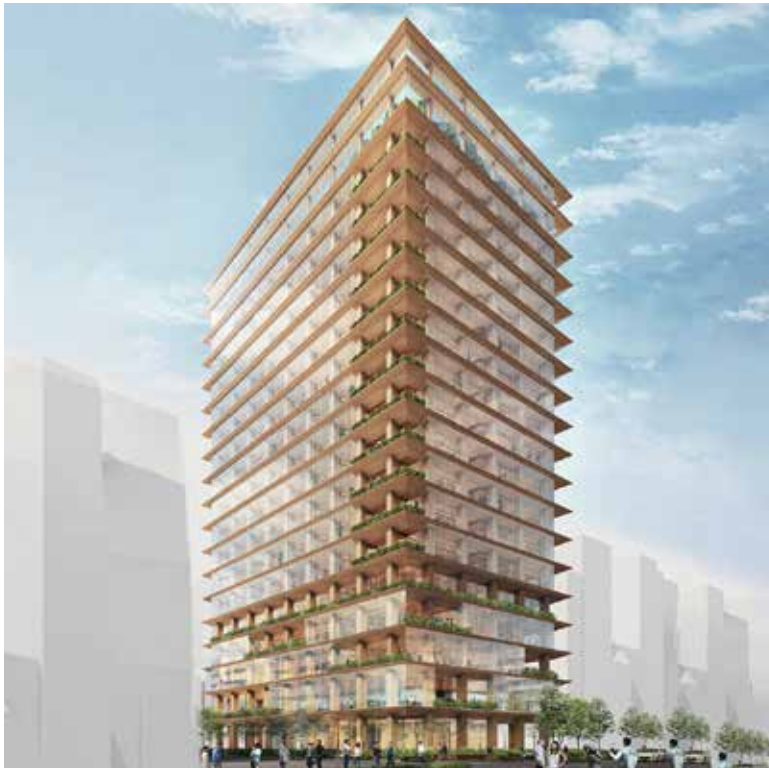
Dự án nhà cao tầng tại Nihonbashi (Tokyo, Nhật Bản) được thiết kế theo tiêu chuẩn chống động đất nghiêm ngặt, ứng dụng hệ thống giảm chấn HiDAX-R hiện đại, giúp giảm 50% biên độ dao động và rút ngắn thời gian rung lắc chỉ còn 1/10 so với bình thường.
