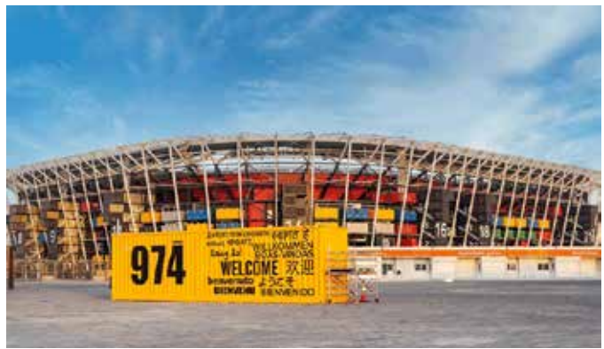
Sân vận động 974 (Qatar) được lắp ghép hoàn toàn bằng 974 container tái chế và thép module.
