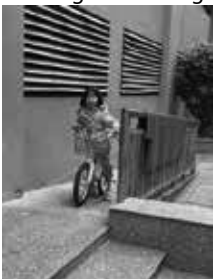
Ram dốc vào công trình
