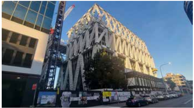
Thi công Bảo tàng Powerhouse Parramatta (Úc).
