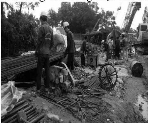
Hình 11. Thực hành gia công cốt thép cầu Sông Phan, Thanh Trù, TP Vinh Yên (cũ)
