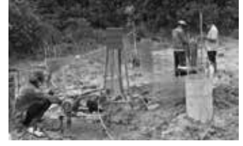
(b) Hiện trường công tác phụt vữa thân cọc
